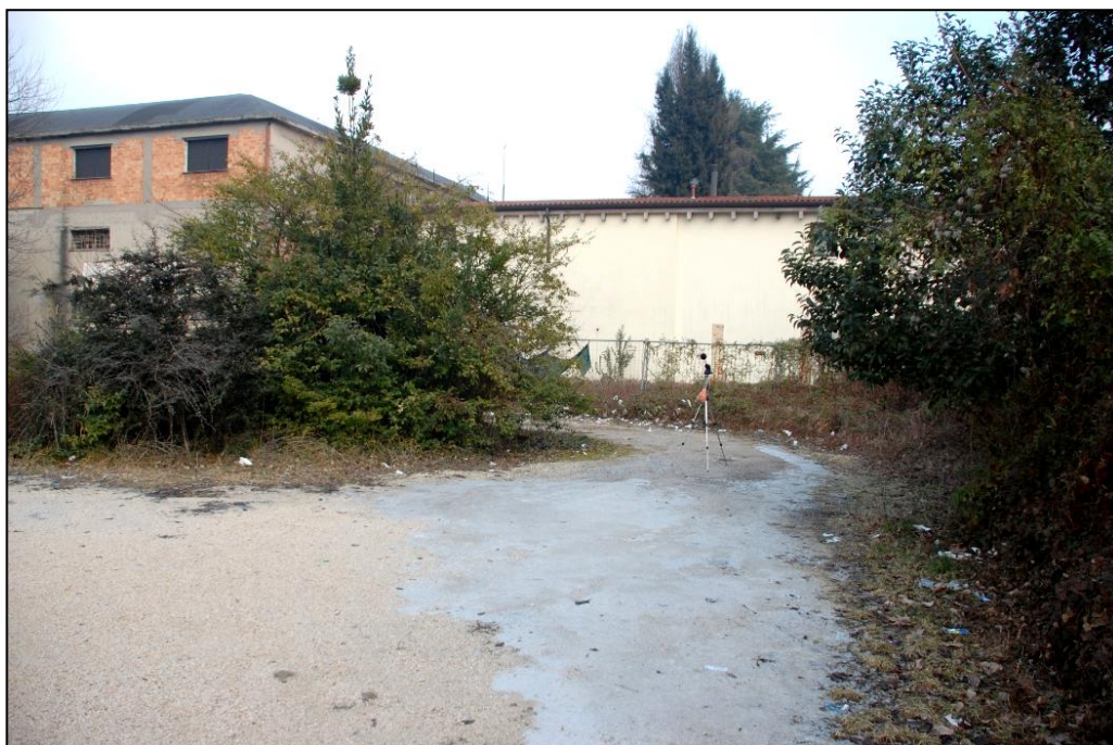
Foto postazione di misura n. 4
