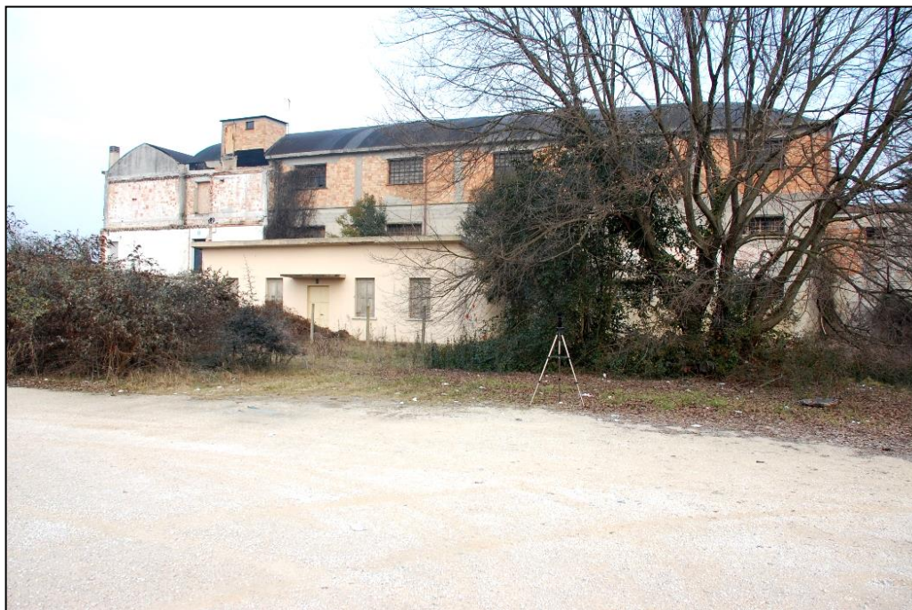
Foto postazione di misura n. 3
